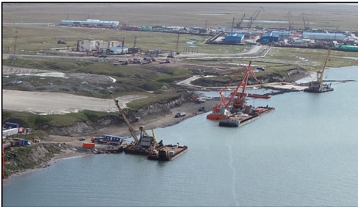
Рис. 7. Подрезка склона для расширения проезжей части на пляже и отсыпка насыпи на морской террасе (мыс Харасавэй)
