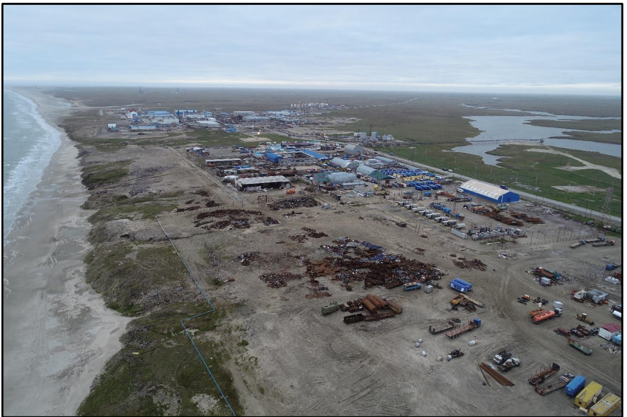
Рис. 12. Вид на поселок Харасавэй. Видны навалы металлолома, мусора и развалины капитальных сооружений в прошлом
